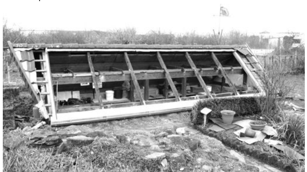
Demoliertes Erdgewächshaus Foto: Kurt Haynberg
